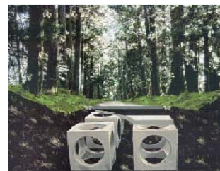
日光杉並木のポカラ工法 「JICE リポート第 2 号」 ／(財)国土技術研究センター
